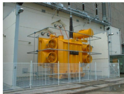
Trafo-chladiče ve VE Orlík
